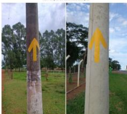
INSTALAÇÃO DE NOVA SINALIZAÇÃO
