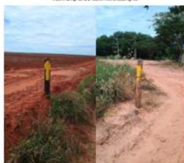
INSTALAÇÃO DE NOVA SINALIZAÇÃO
