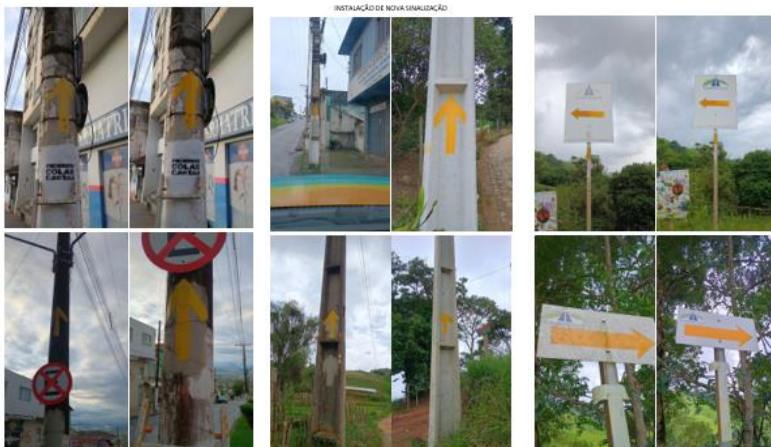
INSTALAÇÃO DE NOVA SINALIZAÇÃO
