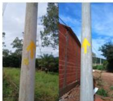
INSTALAÇÃO DE NOVA SINALIZAÇÃO
