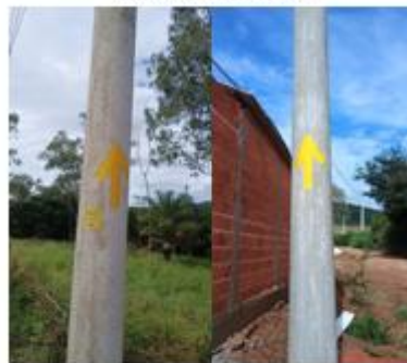
INSTALAÇÃO DE NOVA SINALIZAÇÃO
