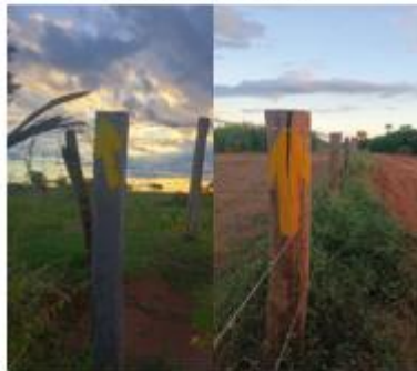
INSTALAÇÃO DE NOVA SINALIZAÇÃO
