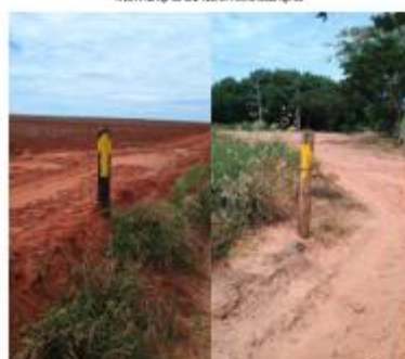
INSTALAÇÃO DE NOVA SINALIZAÇÃO
