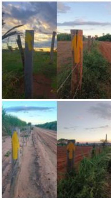
INSTALAÇÃO DE NOVA SINALIZAÇÃO
