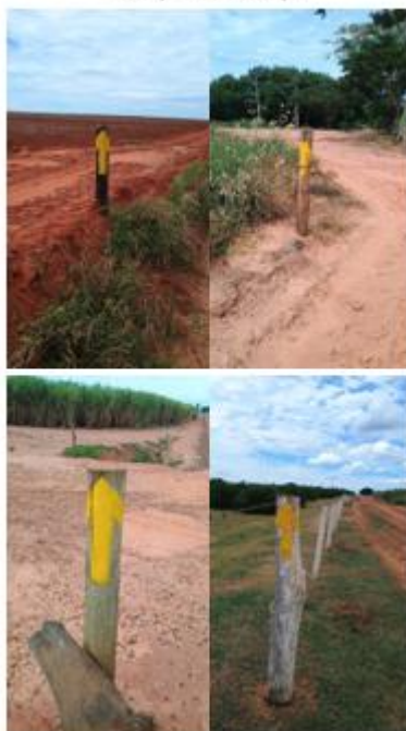
INSTALAÇÃO DE NOVA SINALIZAÇÃO
