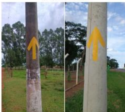
INSTALAÇÃO DE NOVA SINALIZAÇÃO
