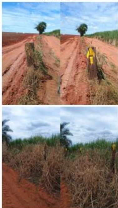
REFORÇO NA SINALIZAÇÃO
