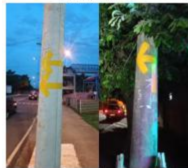
INSTALAÇÃO DE NOVA SINALIZAÇÃO
