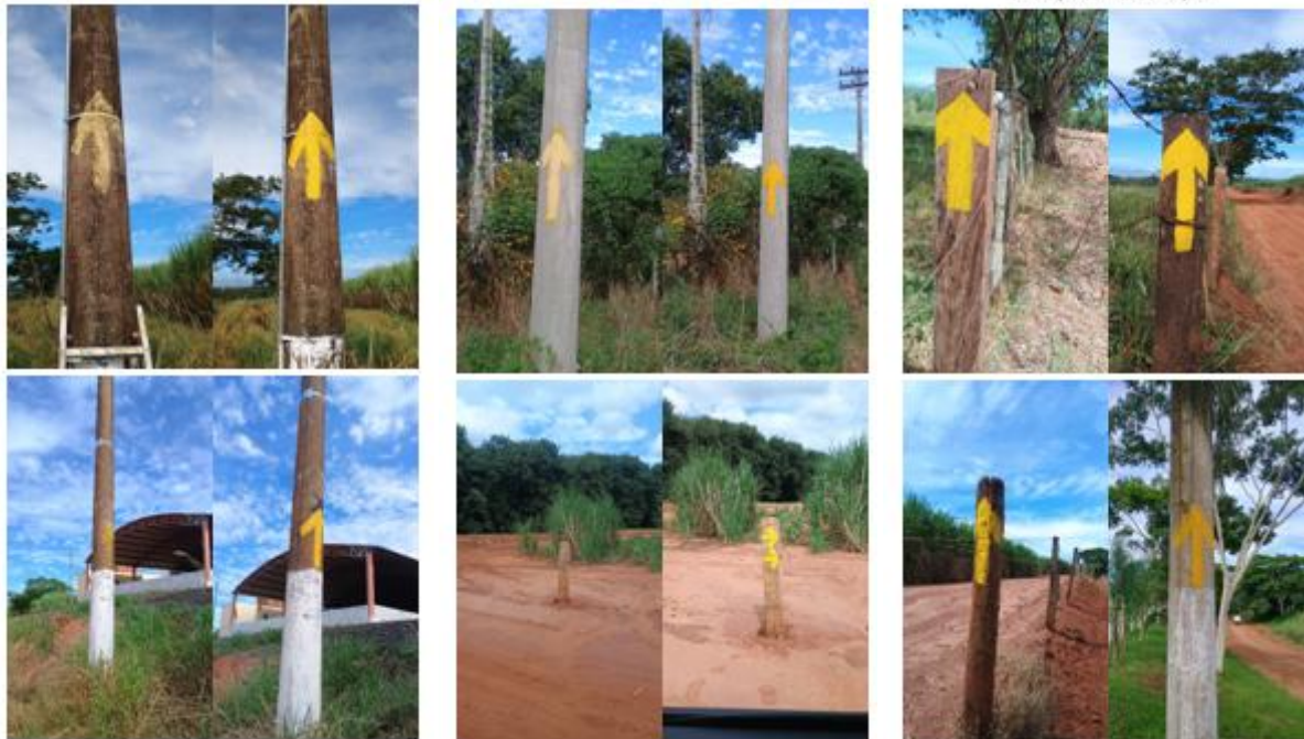
INSTALAÇÃO DE NOVA SINALIZAÇÃO
