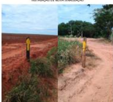
INSTALAÇÃO DE NOVA SINALIZAÇÃO
