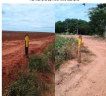
INSTALAÇÃO DE NOVA SINALIZAÇÃO
