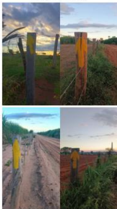
INSTALAÇÃO DE NOVA SINALIZAÇÃO
