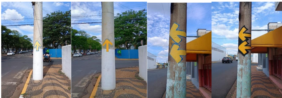
AGUAÍ - INSTALAÇÃO DE NOVA SINALIZAÇÃO
