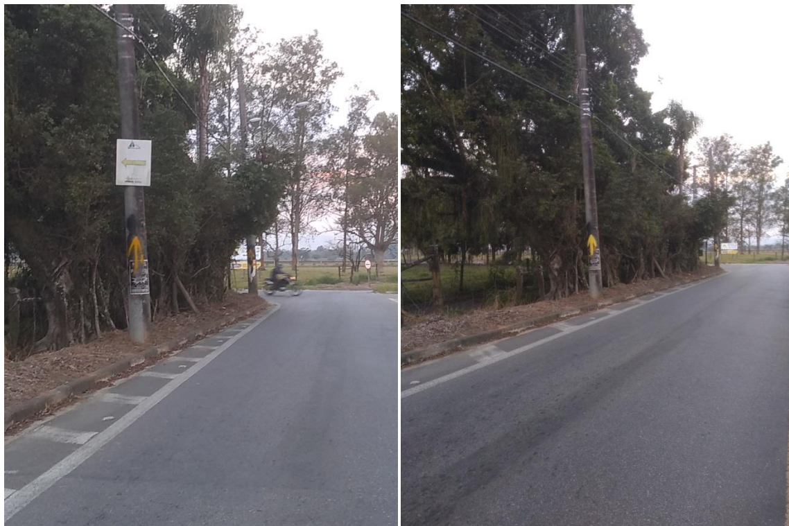
FOTOS 3 E 4: ANTES E DEPOIS DA ALTERAÇÃO NA ENTRADA DO RIBEIRÃO GRANDE
