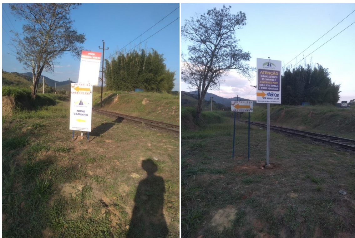
FOTOS 1 E 2: SUBSTITUIÇÃO DE SINALIZAÇÃO ALERTANDO SOBRE MUDANÇA NO TRECHO
